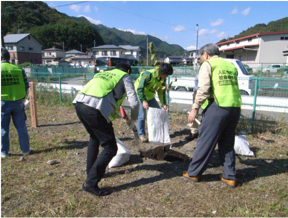
③定住促進住宅敷地での植樹作業。
